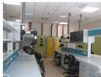
Ciò ha comportato, per esempio, l'installazione di sistemi di espulsione dell'aria per le cappe microbiologiche (MSC: Microbiology Safety Cabinet) e per gli armadi di sicurezza che generalmente lavorano a ricircolo.
