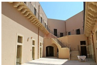
L'interno del Forte
